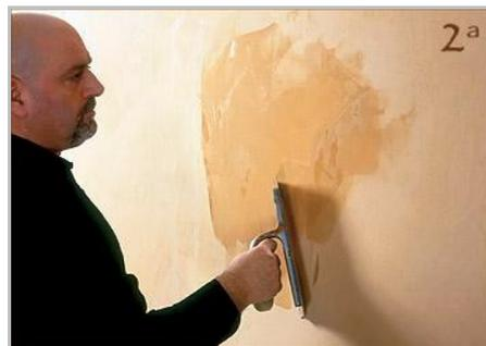
Schritt 4 - Zweiter Anstrich, das Produkt frei mit der Schwammkelle verteilen.
